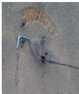
Zamurowane okno na ścianie wschodniej
