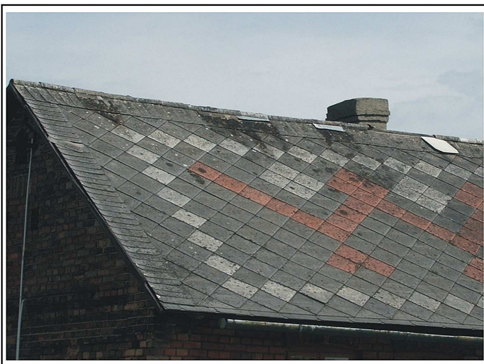
Fot.2 Pokrycie dachowe budynku mieszkalnego z płytek typu "caro" - II stopień pilności
