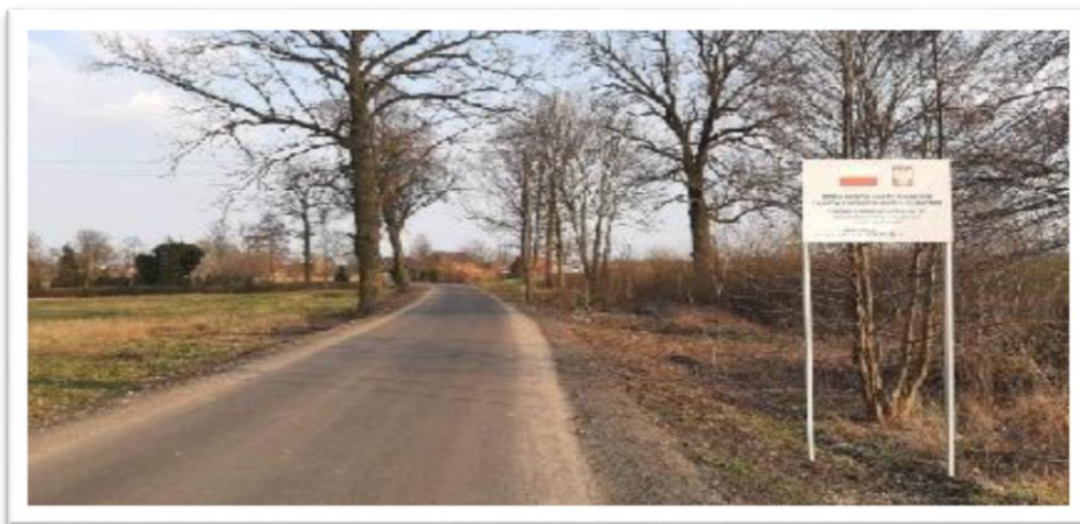
fot. droga wewnętrzna w m. Jelenin.
