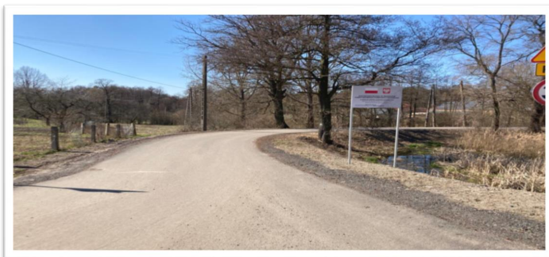
fot. przebudowa drogi w m. Dzietrychowice
