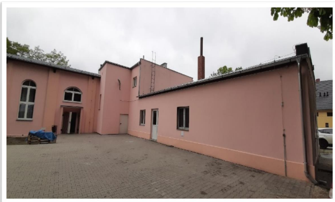
fot. świetlica wiejska w Bożnowie
