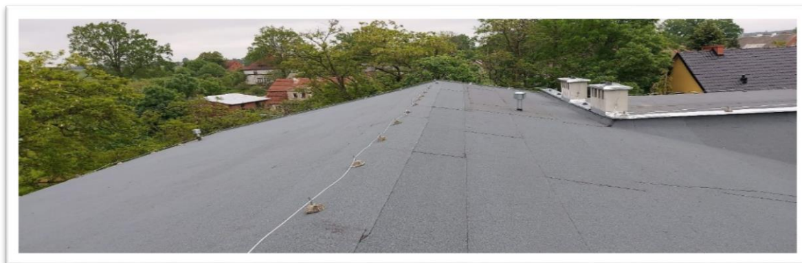
fot. świetlica wiejska w Bożnowie
